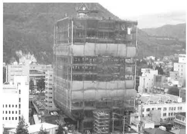
写真2 鉄骨上棟時外観(東面)
