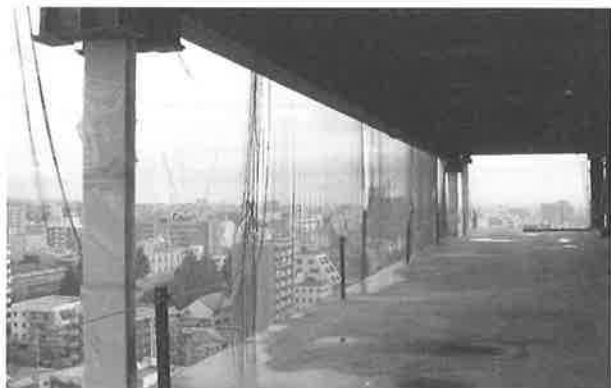
写真3 外壁面の吊り柱 (基準階)
