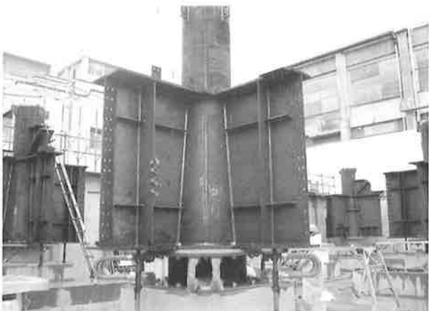
写真1 0節鉄骨建方状況
