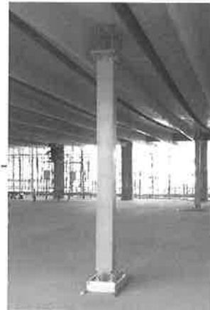
図3 床制振用粘弾性ダンパー
