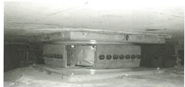
写真6 免震装置据付完了
