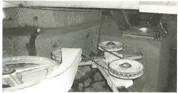
写真3 ワイヤソーによる柱脚部切断
