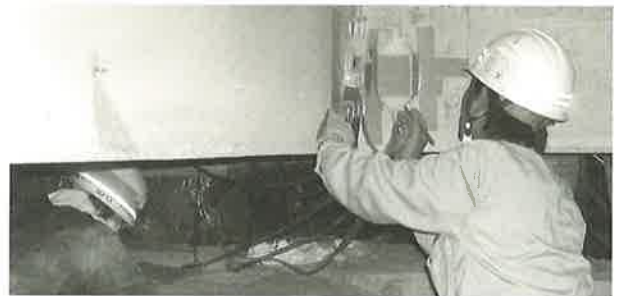
写真5 エポキシ樹脂の注入
