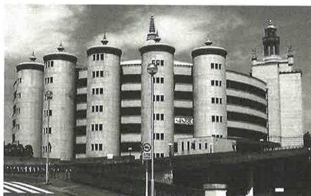
写真1 既存建物外観
