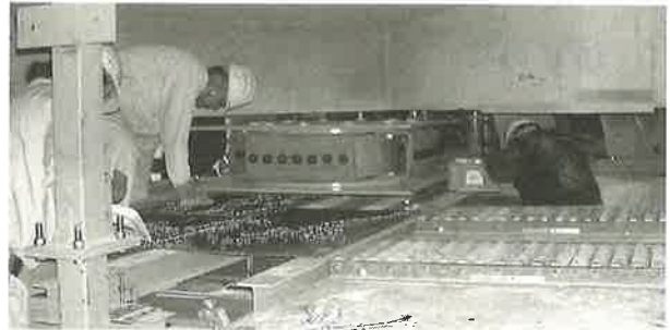
写真4 免震装置の搬入
