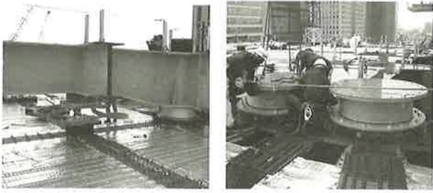
図5 免震層の建方状況
