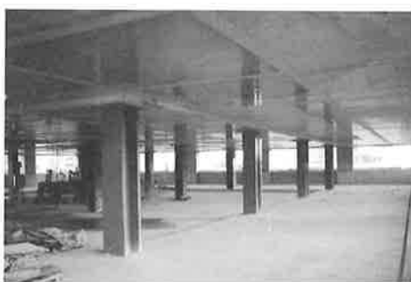
基準階躯体状況
