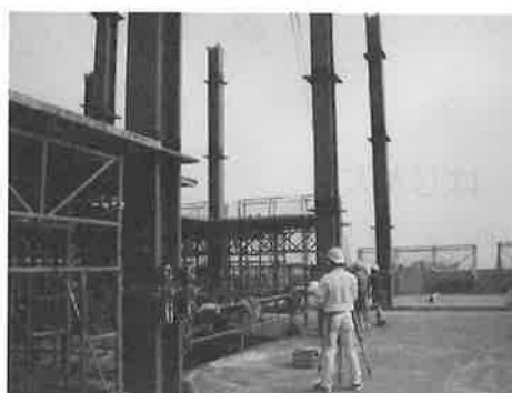
鉄骨柱建方とフライングジョア
