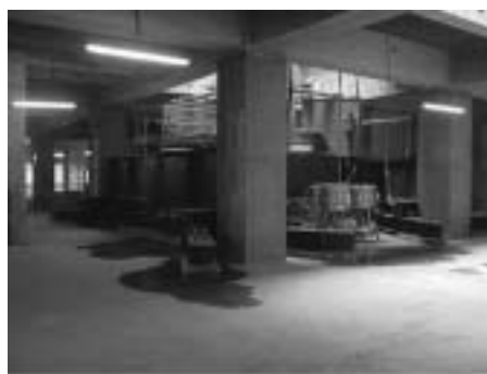
■図8 タワークレーン基礎設置状況写真
