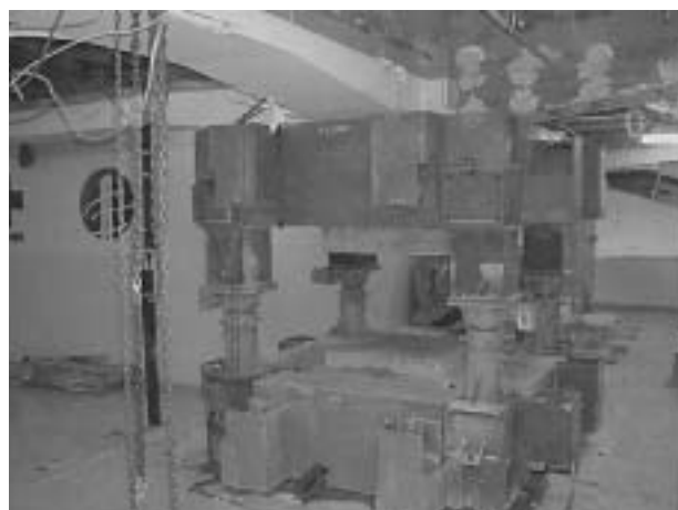
写真2 仮設治具の設置と柱切断状況
