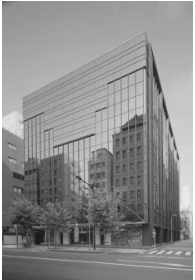
写真4 改修施工後外観
