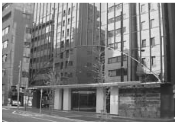
写真1 既存建物外観
