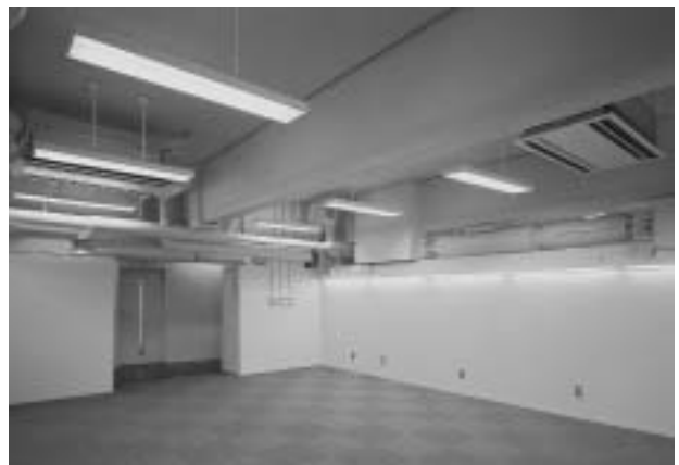
図12 3階免震層の内観写真
