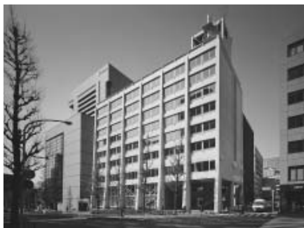
図1 外観写真(改修後)
