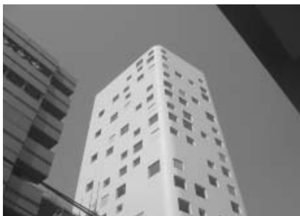
写真4 南面,南東面外殻壁
