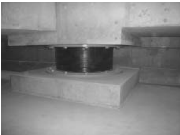
写真2 鉛プラグ入り積層ゴム
