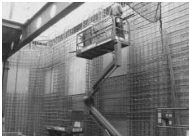
写真3 壁配筋施工状況
