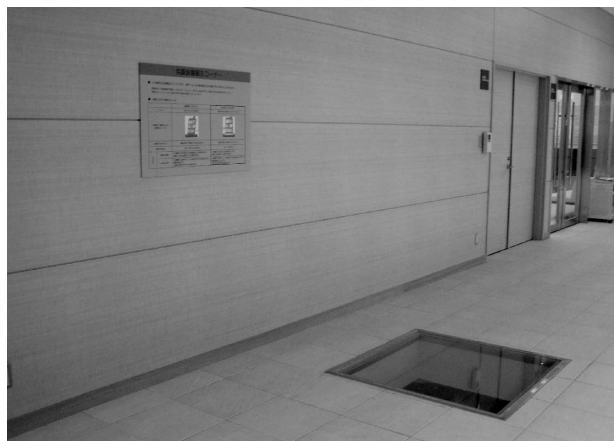
写真5 免震装置展示コーナー
