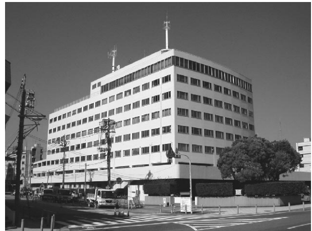
写真1 改修前の建物全景
