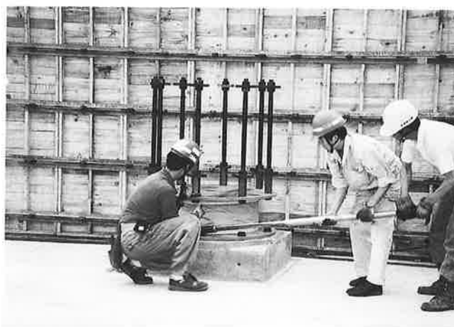
写真-3 免震装置の設置状況
